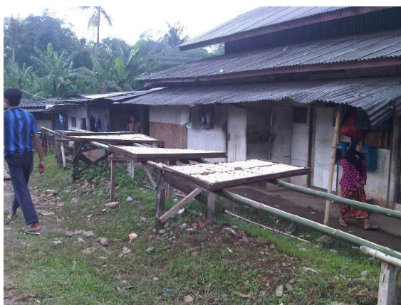
Gambar 1. Bangunan Pabrik Kerupuk Manunggal Karsa
